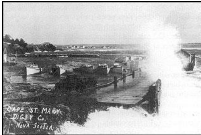
La mer qui ravage le quai au cap Sainte-Marie
